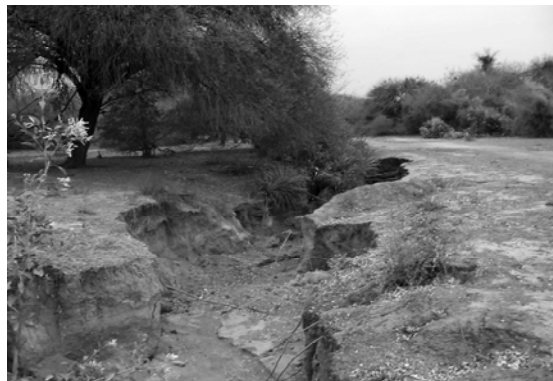
Figura 3. Foto de cárcava.
