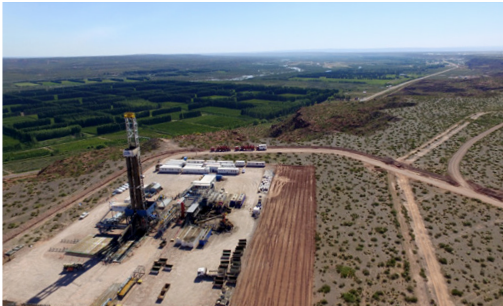
● Well drilling in Loma La Lata Norte area, Añelo, Neuquén province (Image: Fabián Ceballos)
