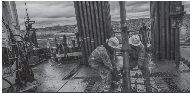
Obreros boca de pozo en el área Sierras Blancas, operada por Shell.
